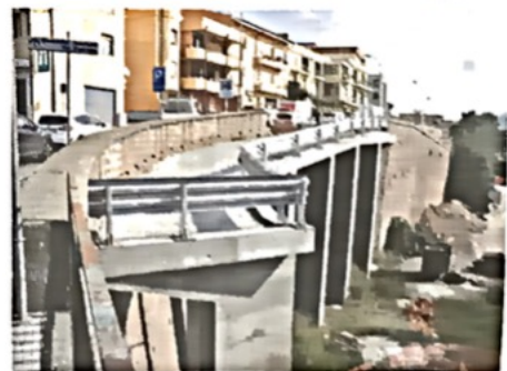
I lavori al centro intermodale (foto Locci)
